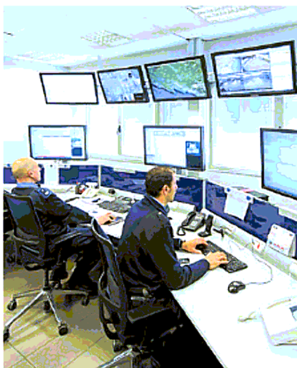
La sala operativa della Lince
